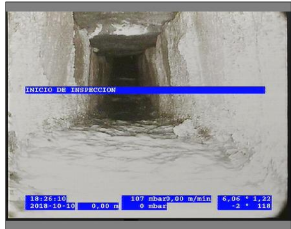
Foto: 4_2A 0m, INICIO DE INSPECCION / Ninguna, dentro de los parámetros admisibles
