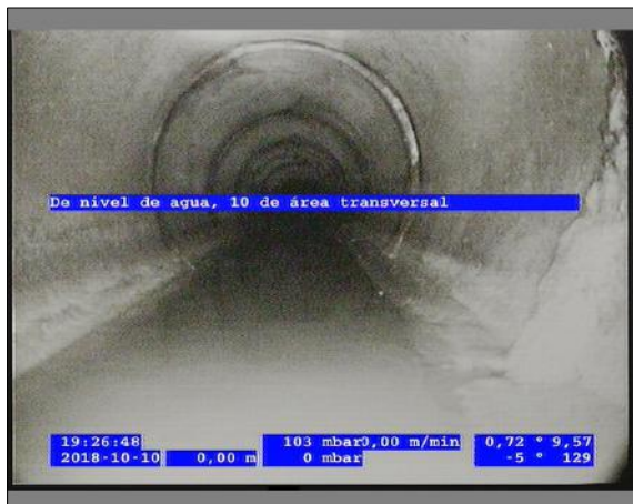
Foto: 6_3A 0m, De nivel de agua, 10 de área transversal / Ninguna, dentro de los parámetros admisibles
