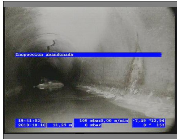
Foto: 6_10A 11,27m, Inspeccion abandonada / Ninguna, dentro de los parámetros admisibles
