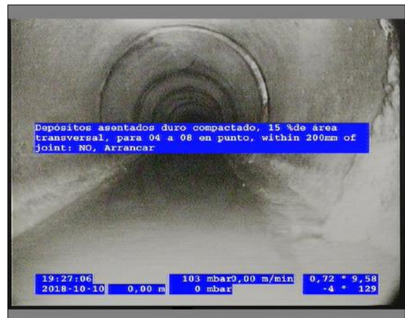
Foto: 6_4A 0m, Depósitos asentados duro compactado, 15 %de área transversal, para 04 a 08 en punto, within 200mm of joint: NO, Arrancar / Se recomienda la limpieza
