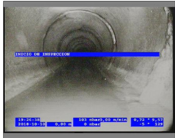
Foto: 6_2A 0m, INICIO DE INSPECCION / Ninguna, dentro de los parámetros admisibles
