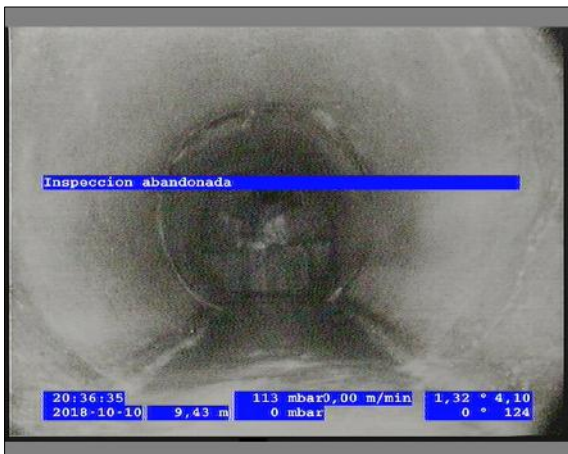
Foto: 9_7A 9,43m, Inspeccion abandonada / Ninguna, dentro de los parámetros admisibles
