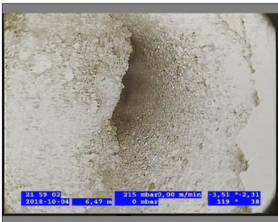
Foto: 1_5B 6,47m, Conexión por rotura, en 10 en punto, 150mm, within 200mm of joint: NO / Ninguna, dentro de los parámetros admisibles
