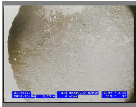
Foto: 1_7B 8,13m, Conexión por rotura, en 10 en punto, 150mm, within 200mm of joint: NO / Ninguna, dentro de los parámetros admisibles
