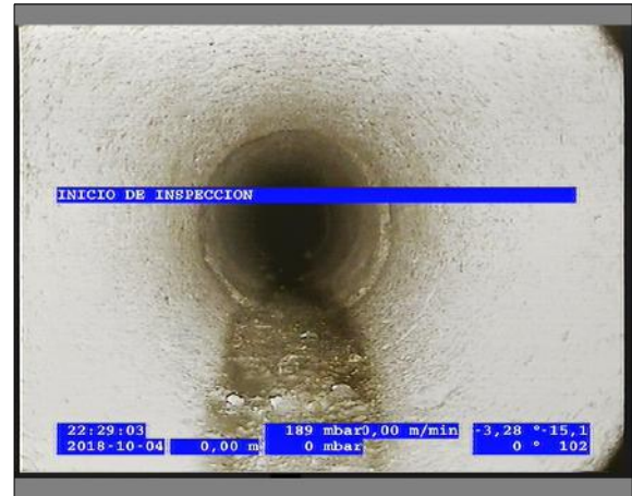
Foto: 2_2A 0m, INICIO DE INSPECCION / Ninguna, dentro de los parámetros admisibles
