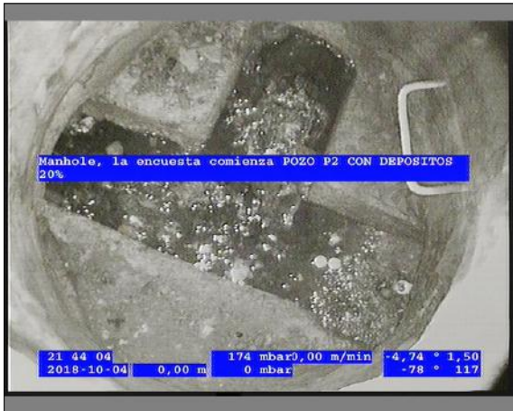
Foto: 2_1A 0m, Manhole, la encuesta comienza / Ninguna, dentro de los parámetros admisibles
