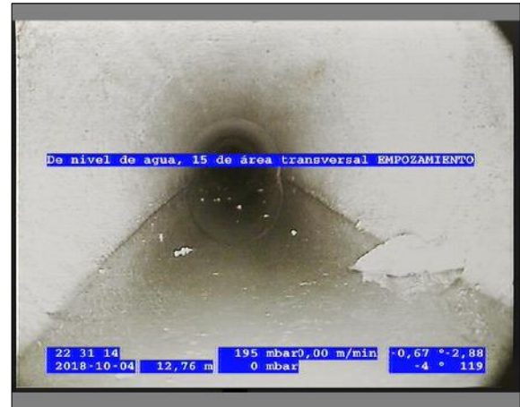
Foto: 2_6A 12,76m, De nivel de agua, 15 de área transversal EMPOZAMIENTO / Se recomienda la limpieza
