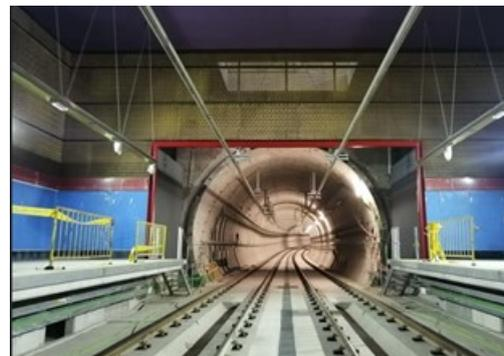
**\*Avance de la construcción del túnel:** En la estación El Labrador se encuentra pendiente el cierre del fondo de saco por cuanto aún se mantiene bajo análisis la factibilidad la construcción de la extensión de la PLMQ hacia el sector de La Ofelia. El fondo de saco es el espacio donde estacionan los trenes y donde se realiza el cambio de vías para que puedan retornar hacia el sur.
