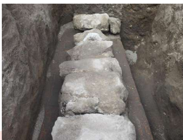
Fotos 92 Unidad 20, Detalle de ducto cajón
