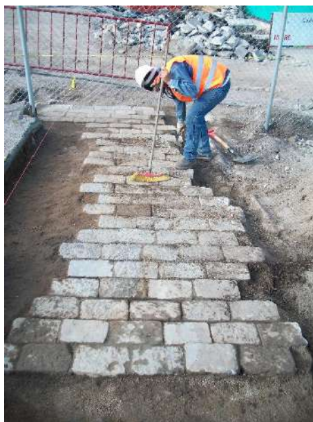
Foto 33 Unidad 7, piso expuesto por excavación
