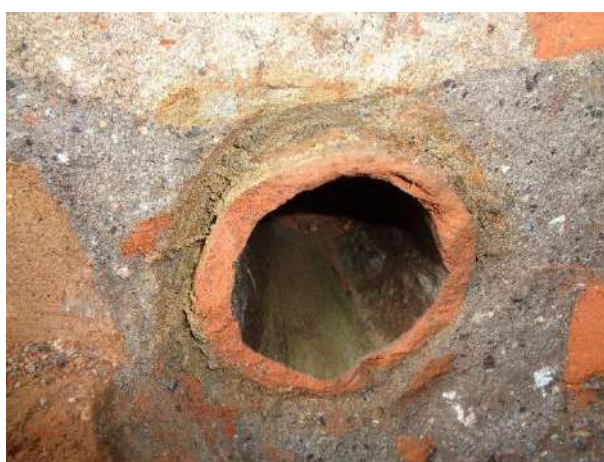
Foto 48 Unidad 2 Tubería de cerámica, detalle constructivo
