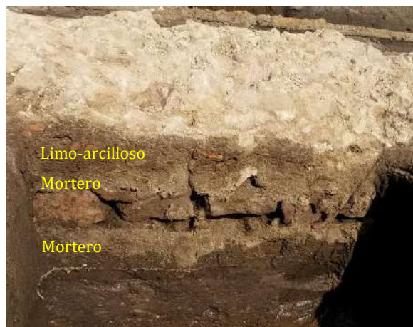
Foto 30 Cimiento de estructura octagonal
