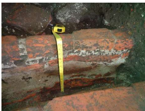
Foto 53 Unidad 2, conjunto 2 detalle constructivo de la Hilera 1
