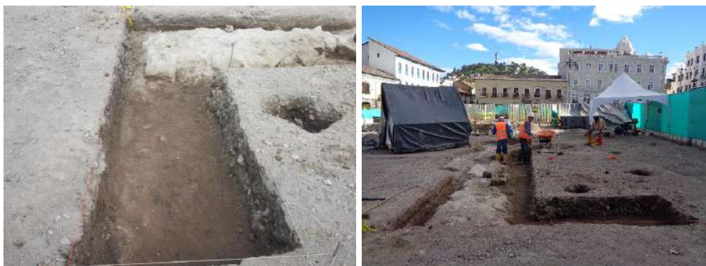
Foto 81 y 82 Unidad 20, Esquina NE, ausencia de basamento
