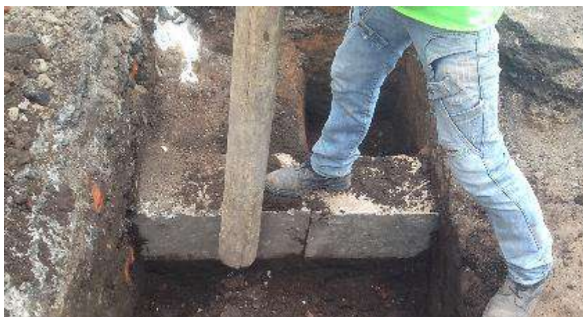
Foto 125 Unidad 30, detalle de estructura de cemento
