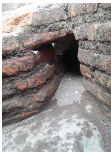
Foto 91 Detalle de unión con caja de sedimentación
