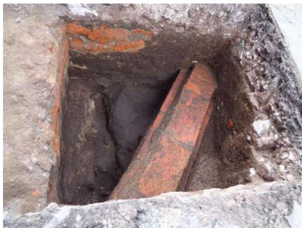
Foto 122 Unidad 19, canal de ladrillo
