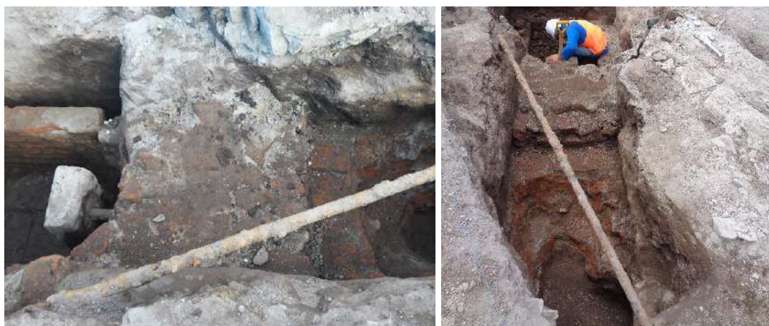
Foto 86 y 87 Unidad 20 Detalles de ducto matriz
