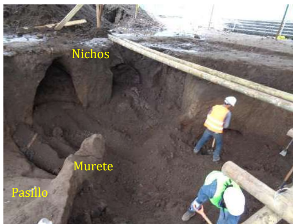
Foto 17 Elementos al interior de cámara 2
