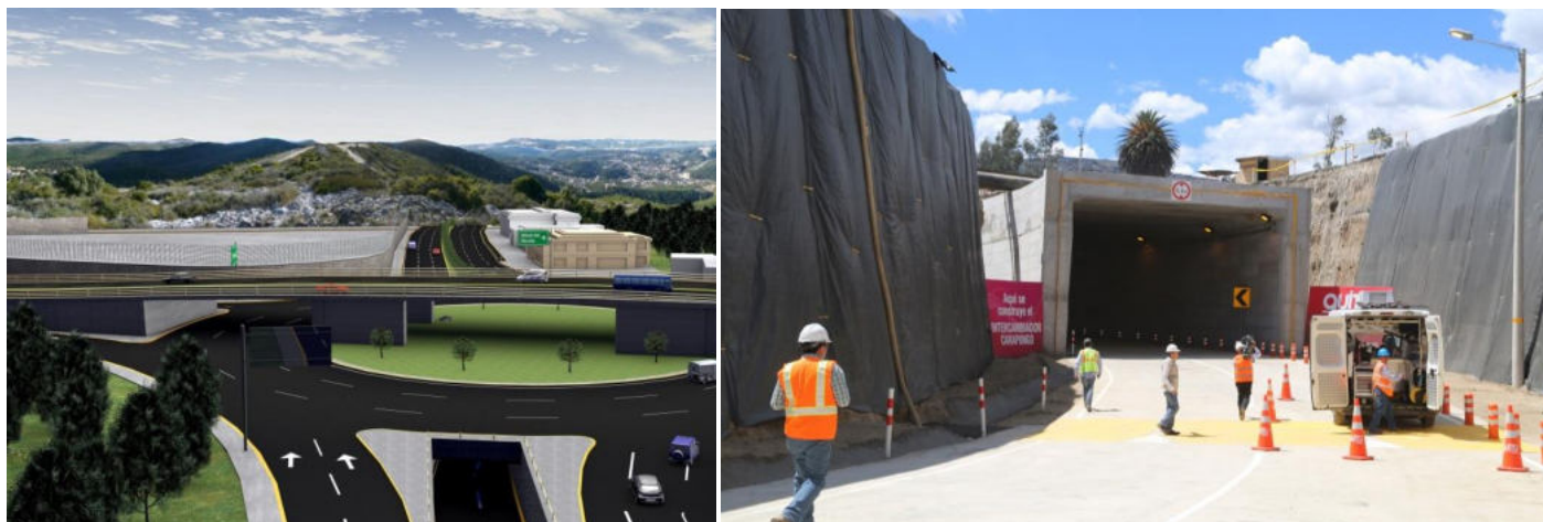
Fotos: Construcción Intercambiador Carapungo
