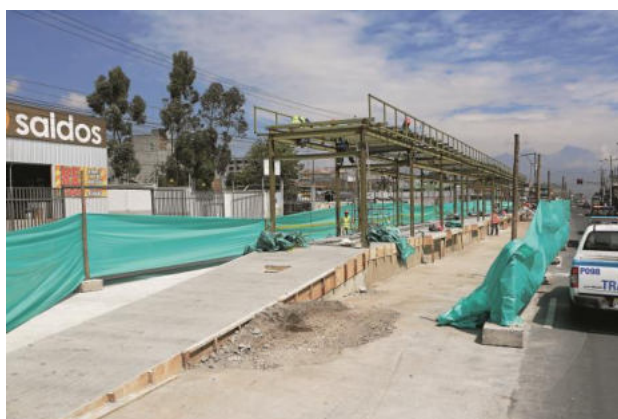
Foto: Construcción Nueva terminal Guamaní
