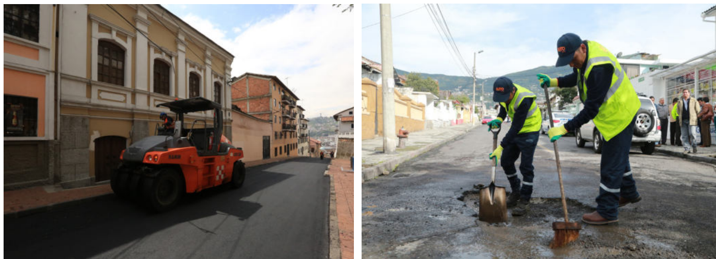
Foto: Programa de Rehabilitación y Mantenimiento Vial
