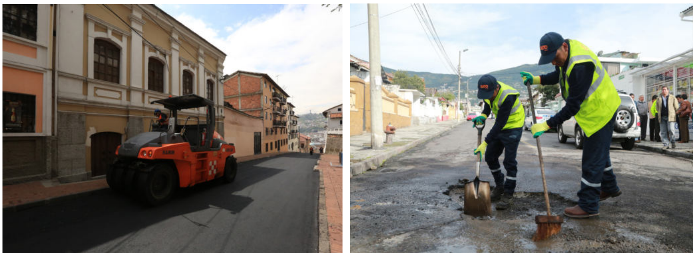
Foto: Programa de Rehabilitación y Mantenimiento Vial
