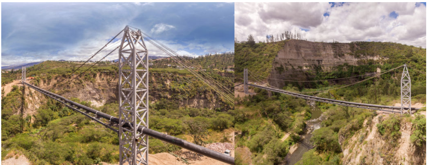
Fotos: Pasos elevados de agua
